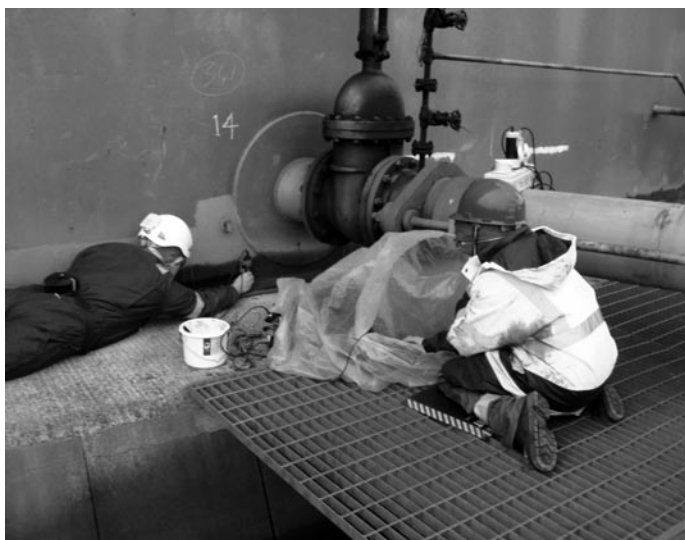
貯蔵タンクの壁と床板の内側隅肉溶接部のフェイズドアレイ検査
